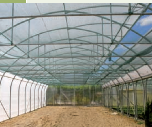
Fot. 1. Konstrukcja tuneli wykonana jest z łatwych do montażu elementów ocynkowanych, które nie wymagają konserwacji fot. 1–3 M. Podymiak
