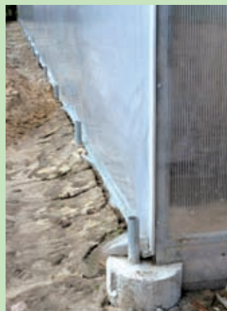
Fot. 4. Rurki zagłębione w stopach betonowych umożliwią rozbudowę tunelu
