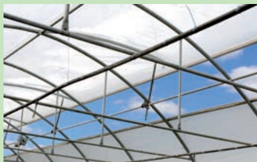
Fot. 5. Wietrzniki w tunelu foliowym fot. 1–5 M. Podymniak
